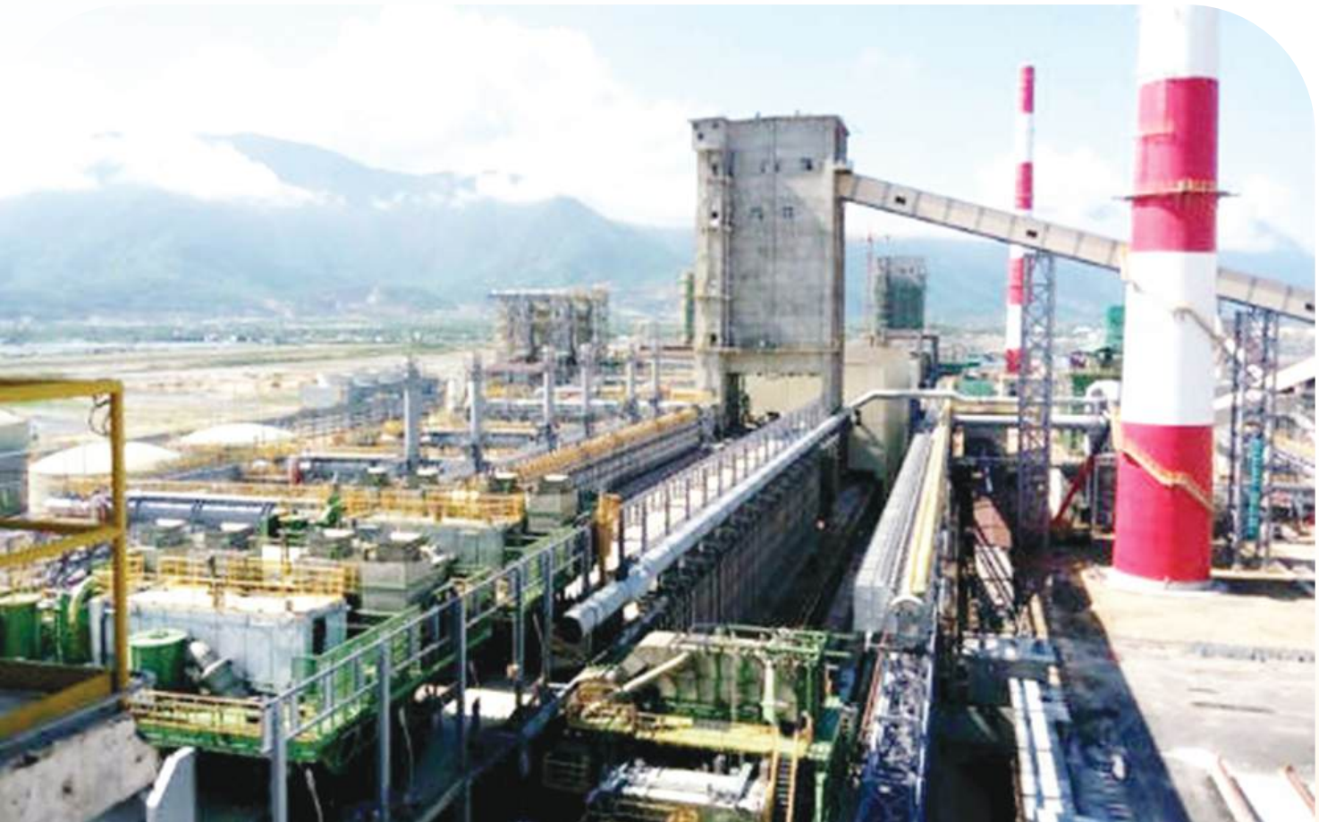
Dây chuyền tiếp nhận và cung ứng nhiên liệu than nhập khẩu của Formosa (Ảnh sưu tầm trên https://vneconomy.vn/cho-formosa-duoc-nhap-than-truc-tiep-tu-nuoc-ngoai.htm , ngày 27/10/2016).
