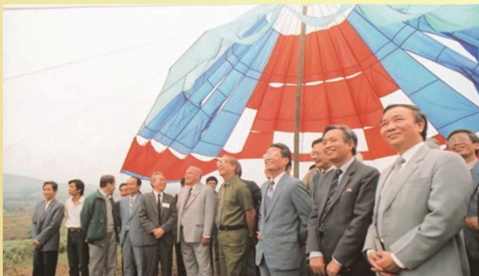
Lễ khởi công xây dựng đường dây 500 KV xuyên việt.
