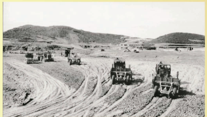
Thi công công trình thủy lợi lớn Kè Gỗ (Hà Tĩnh).
